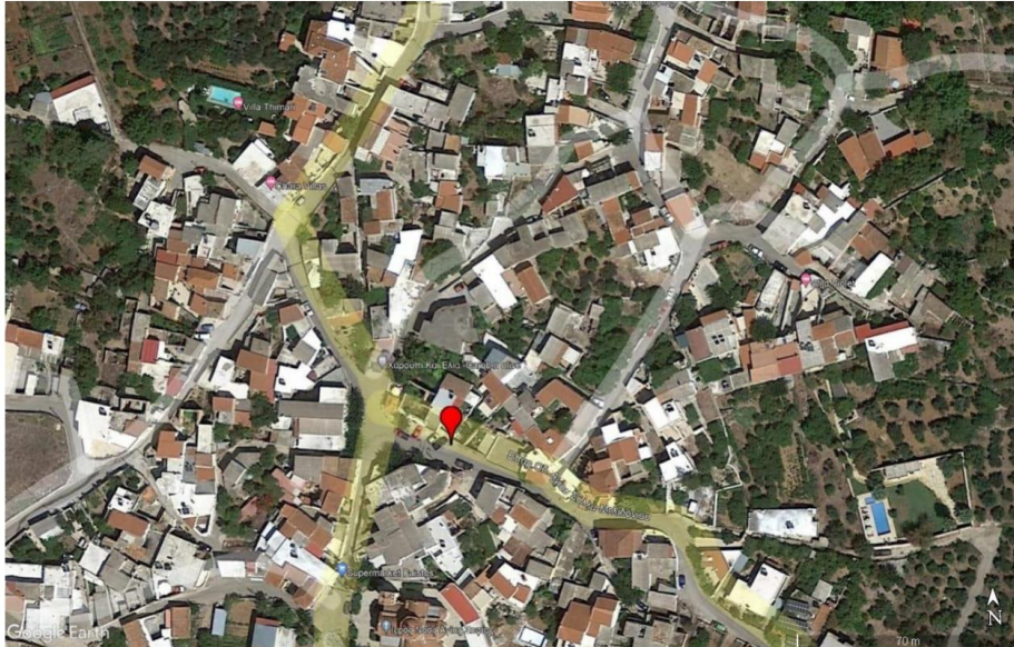
Εικόνα 18: Οικισμός «Μελιδόνι»-Επί της οδού
